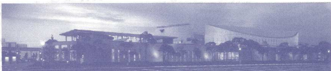
田原町図書館及び生涯学習施設全景
