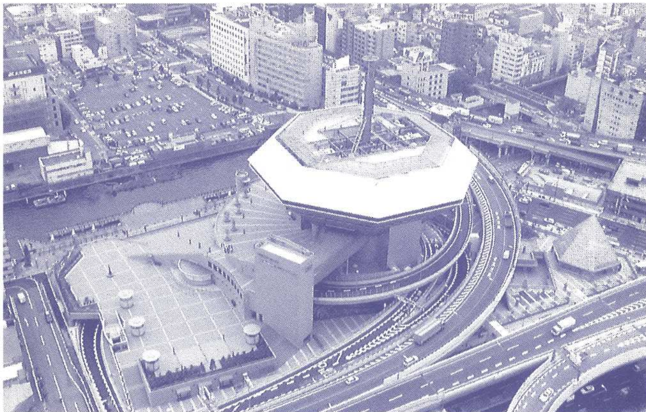
南側全景(空撮)
